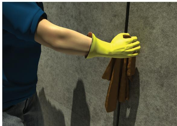
Figura 3.5: Junta de dilatação sendo limpa para preenchimento posterior com material flexível (Fonte: <http://sandbox.cachina.com.br/sites/cascola/passos.html>)
